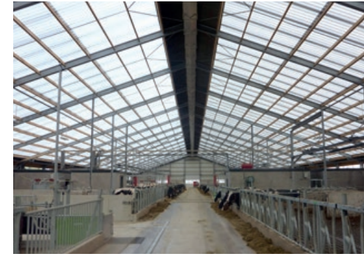
Toit entier avec plaques translucides
